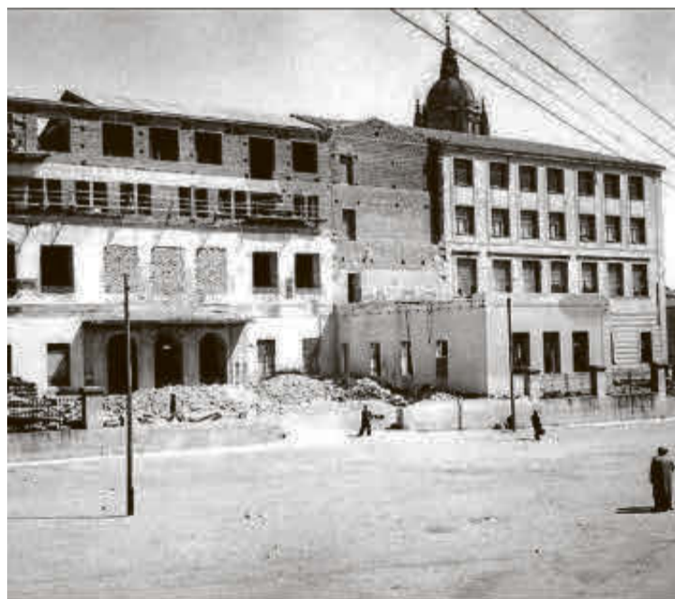
Imagen del derribo del edificio Trilingüe en 1977.
